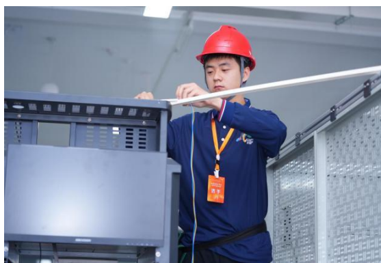
图 2-10 2024 年世界职业院校技能大赛“建筑智能化系统与安装”选手调试设备
