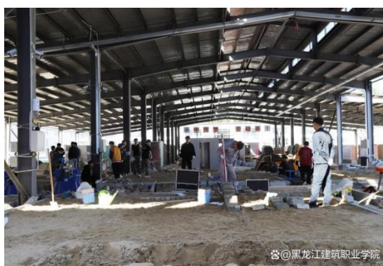
图 6-13 学院建筑实训基地保障教学质量
